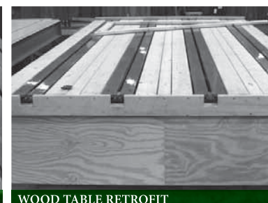
WOOD TABLE RETROFIT
